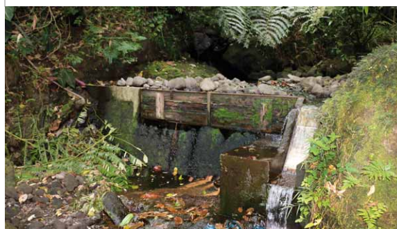
Le captage de Maatea servira à alimenter la future usine de traitement des eaux
