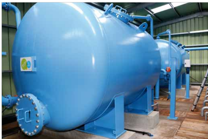
Usine de traitement d'eau de Papetoai mise en service en juillet 2017
