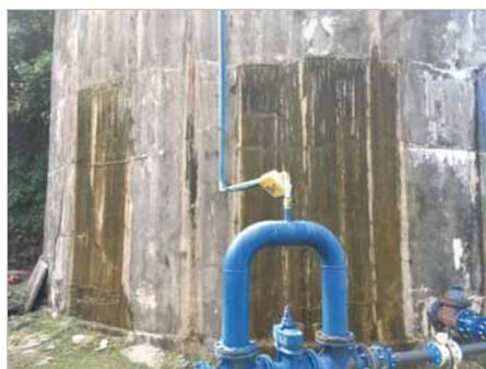
Le réservoir de 500 m3 de Paopao présente des fuites d'eau et une érosion des voiles béton internes
