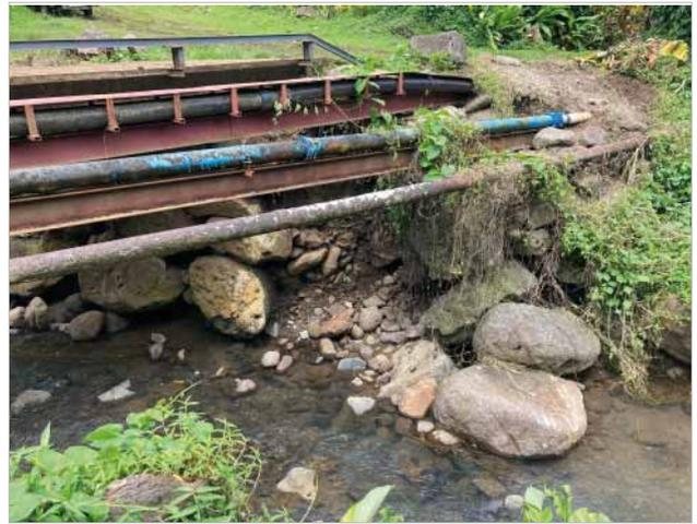
*Un affaissement de terrain avec des rochers qui se sont détachés sous le pont d'accès à l'UCD de Haumi, fragilisant ainsi la canalisation de distribution.*
