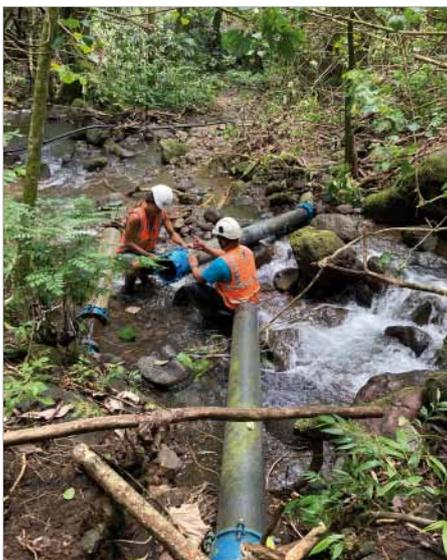
*Le tuyau d'alimentation principale du captage de Haapiti s'est déboîté, en deux endroits, entraînant la rupture de la distribution.*
