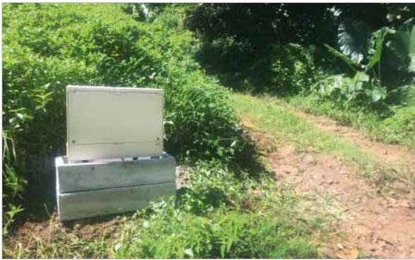
28 coffrets de coupure Basse Tension permettront de réaliser les branchements vers les usagers.
