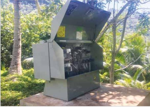
L'installation de 2 postes de transformations Haute Tension ont été nécessaires pour réaliser l'électrification de cette vallée
