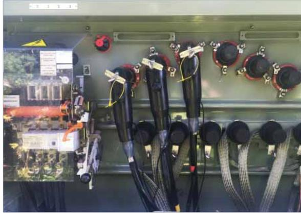
Un organe de coupure Haute Tension a été installé au départ du réseau
