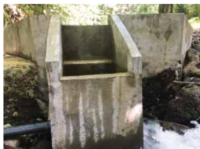
* Grille de filtration Coanda du nom de l'ingénieur à l'origine de la découverte de cet effet physique : Henri Coanda.
