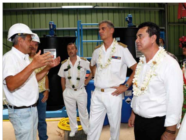
Visite de l'usine de traitement des eaux de Papetoai, conduite par Jean-Pierre LE LOCH responsable de l'agence de Moorea de la Polynésienne des Eaux.
