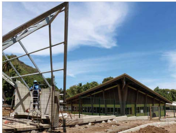
Sur le chantier de l'école bioclimatique de Papetoai, la délégation a constaté l'avancée de la réalisation dont la mise en service est programmée en mars 2020. Le Haut-commissaire a rappelé l'intérêt majeur que présente cette opération bioclimatique pilote dont la maîtrise d'œuvre est assurée par la Direction de l'ingénierie publique du Haut-commissariat, et soutenue financièrement par l'ADEME à hauteur de 15 millions xpf.
