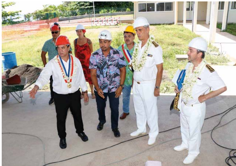
Visite des chantiers, de l'école de Teavaro en cours de finition après de multiples retards dus à des problèmes de construction, et de l'école bioclimatique de Papetoai en cours de travaux
