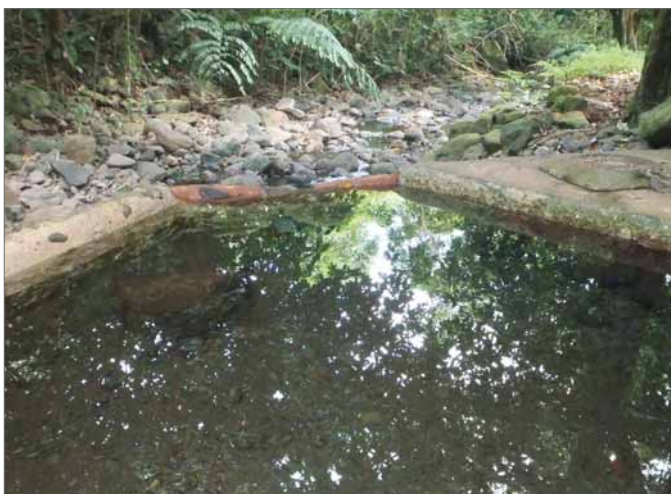
Captage de Atiha en période d'étiage, la rivière en aval n'est plus en charge
