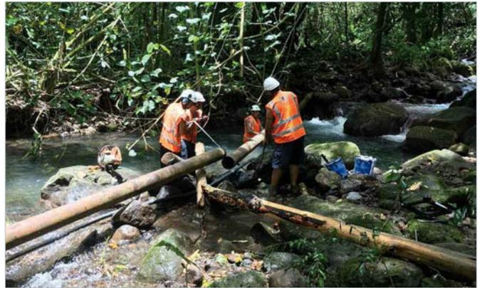
24 janvier – Canal de distribution Vairemu — Haapiti entre le réservoir et la route de ceinture; la canalisation a été déchaussée au niveau d'une jonction.
