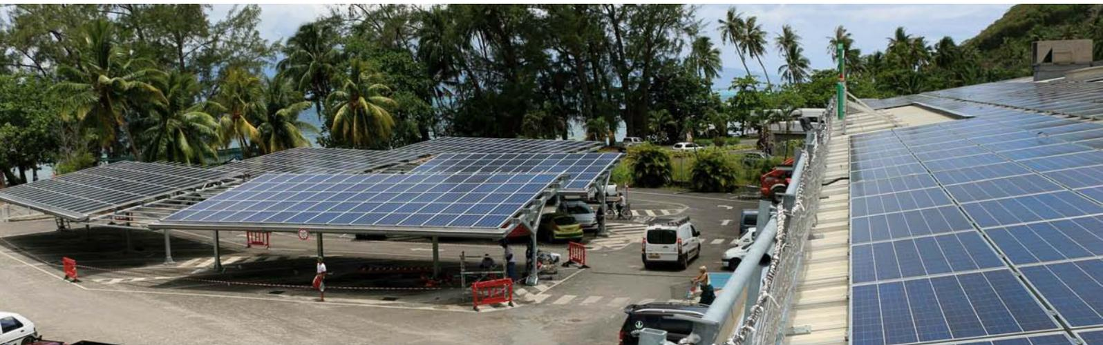
**1132 panneaux solaires couvrant une surface totale de près de 1800m<sup>2</sup>, pour une puissance installée de 300 kWc.**
