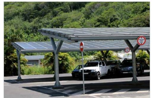
L'ensemble des panneaux est réparti pour  $\frac{1}{3}$  sur les ombrières du parking et pour les  $\frac{2}{3}$  restants sur l'ensemble de la toiture du magasin, soit un total de 1132 panneaux solaires couvrant une surface totale de près de 1800 m<sup>2</sup>, la puissance installée est de 300 kWc.
