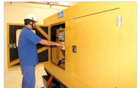
Groupe électrogène de secours pour alimenter les auxiliaires de la centrale.
